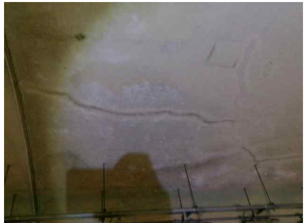
라이닝 S40 천단부 재균열( C_w=0.3\text{mm} 이상)-서울방향
