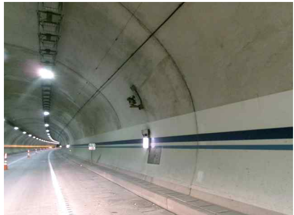
라이닝 우측벽 상태양호-문산방향
