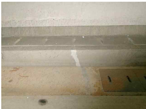
포장부 S27 균열 보수완료-서울방향
