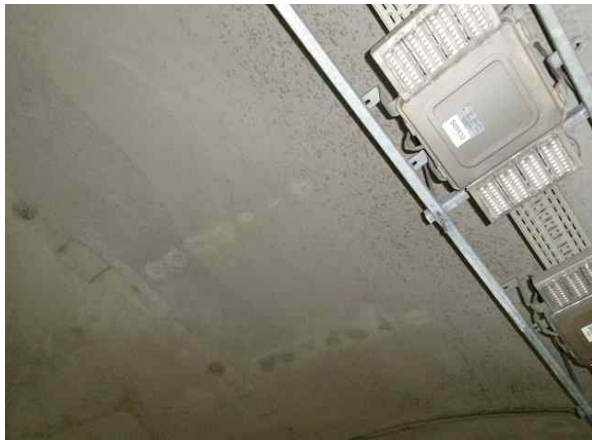
라이닝 S29 천단부 재균열( Cw=0.3\text{mm} 이상)-서울방향
