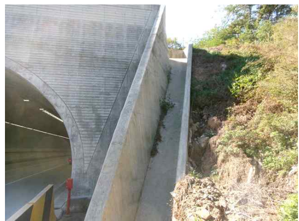
종점측 갭문 배수로 전경-서울방향
