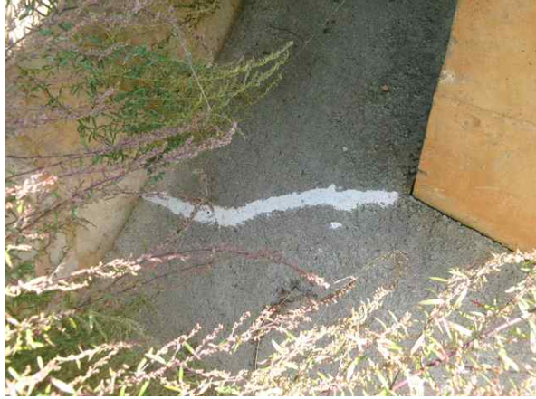
시점측 갭문 균열보수-서울방향
