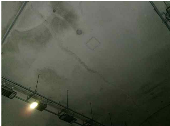
라이닝 S36 천단부 재균열( C_w=0.3\text{mm} 미만)-서울방향
