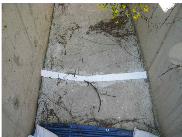
시점측 갭문 배수로 균열 보수완료-문산방향
