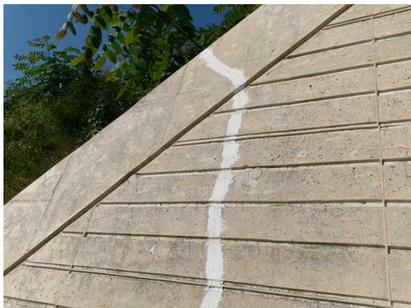
시점측 갭문 균열보수-서울방향
