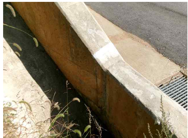
시점측 갭문 균열보수-서울방향
